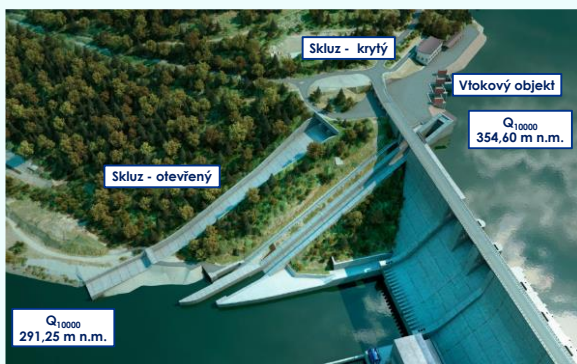
Fyzikálního modelu bezpečnostního přelivu – Měř. 1:50
