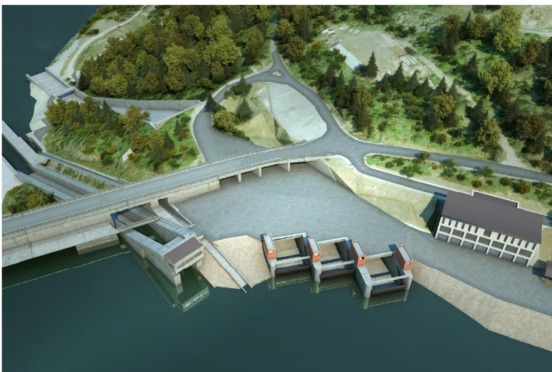
Obr. 2 Vtokový objekt hrazený třemi segmentovými uzávěry [2]
